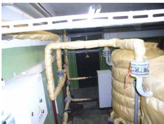
Тепловая установка на базе агрегата кавитационного роторного в системе горячего водоснабжения
