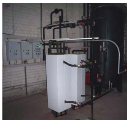
Тепловые установки на базе агрегатов кавитационных роторных в системе отопления с баком-накопителем тепла
