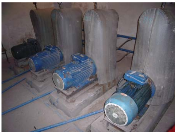
Тепловые установки на базе вихревых теплогенераторов в системе отопления школы
