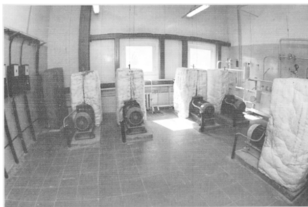
Машинный зал вихревых теплогенераторов
