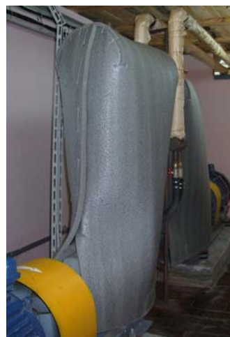
Тепловые установки на базе вихревых теплогенераторов для подогрева ванн в гальваническом цеху
